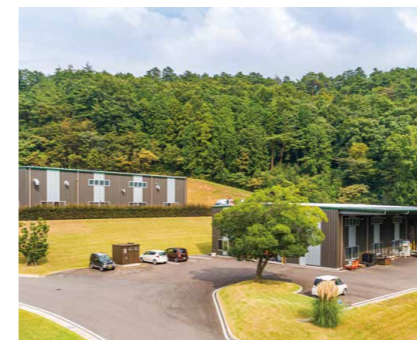
▲敷地入口からのアプローチ
